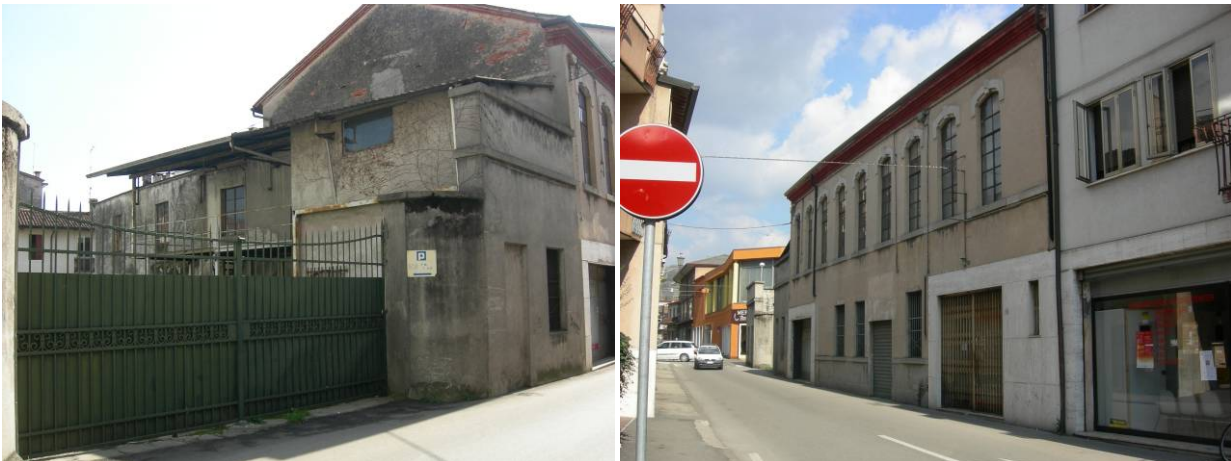
Figura 4 - Unità d'Intervento 16: accesso da via Castellana e vista su via Padre Giuliani
