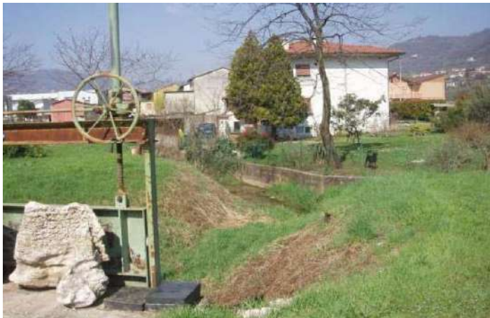
Opera di chiusa a testimonianza del corso d'acqua oggi interrato, presente all'interno del lotto produttivo.
