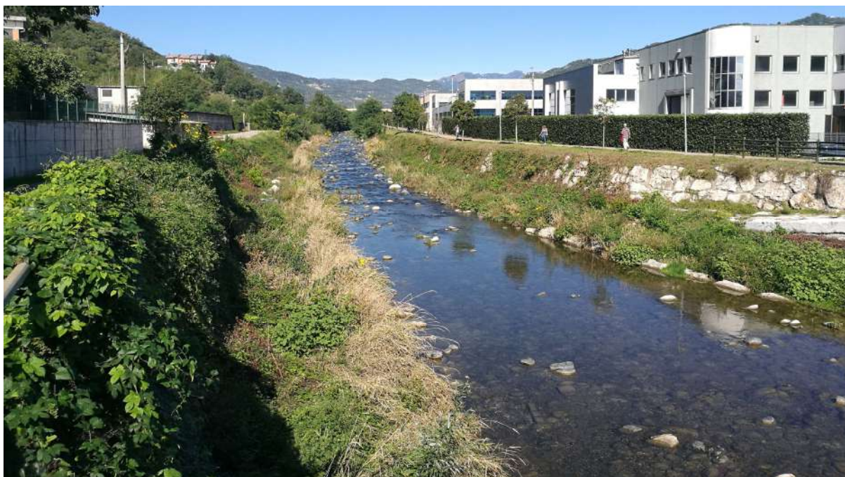
Tratto del torrente Chiampo a delimitazione della zona produttiva di Chiampo, prossima all'area di intervento. La ripresa è effettuata da via Fiume.
