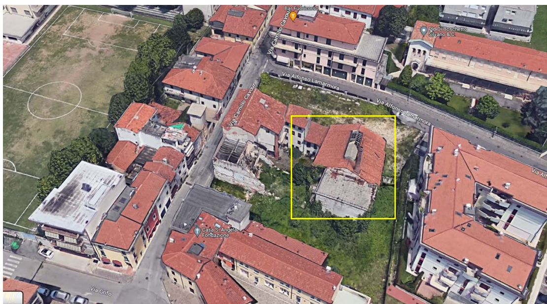
Individuazione del sito dell'ex filanda sulla carta dei vincoli e delle invarianti del PAT. E immagine satellitare che mostrano le condizioni di degrado del sito, posto in pieno centro cittadino. Si segnala l'edificio dell'ex filanda con la ciminiera e il lucernario.
