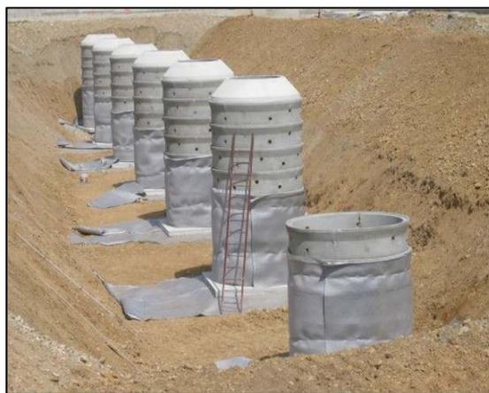
Esempio di realizzazione di una serie di pozzi perdenti
